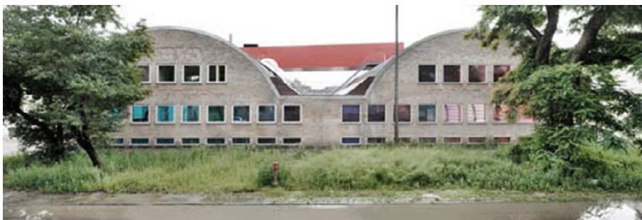
Sjakkets bygninger på Skaffervej, Ydre Nørrebro. Imellem de to haller er der skabt en tagterrasse. På tværs over tagterrassen er der opsat en container, der bruges som musik- og øvelokale. Foto: Sjakket.
